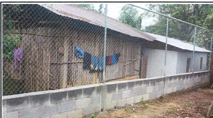
Foto 3: MEJORAMIENTO DE MURO: Se realizo el muro al 100%
