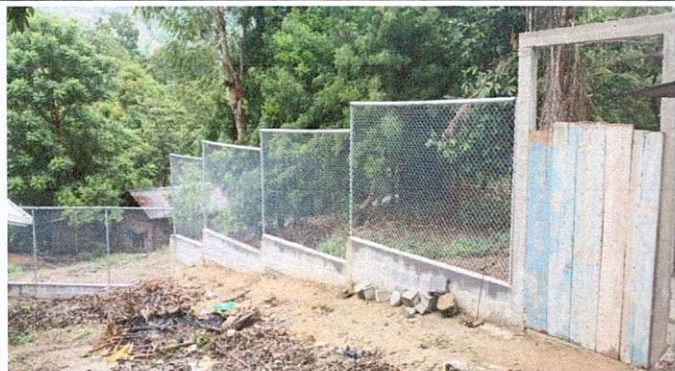
Foto1: MEJORAMIENTO DE MURO: Se realizo el muro al 100%
