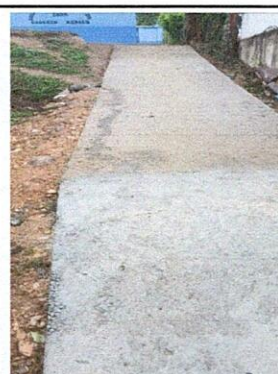
Foto 4: MEJORAMIENTO DE CAMINAMIENTO: Se realizo el caminamiento al 100%
