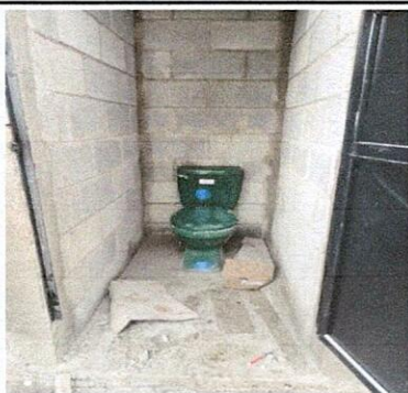
Foto 5: MODULO BAÑO: Se realizo neajoramiento en los baños del 100%
