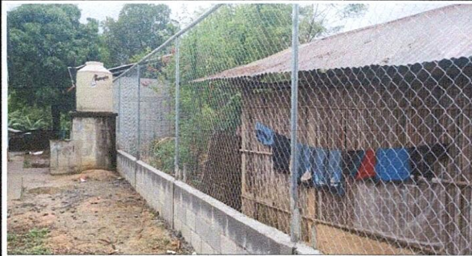
Foto 2: MEJORAMIENTO DE MURO: Se realizo el muro al 100%
